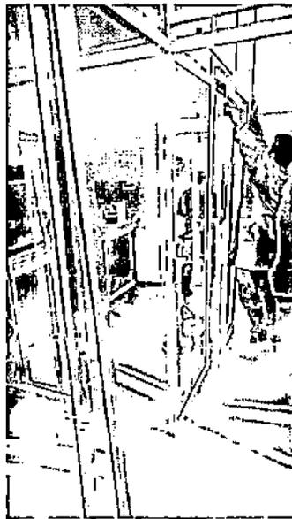
2. Despernado de mesón existente para el retiro de este. El mesón está estructurado de perfiles de aluminio sobre los cuales está pegada la plancha de granito y los salpicaderos. La estructura
